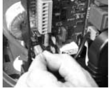
Entfernung der Motorkabel von dem KS
