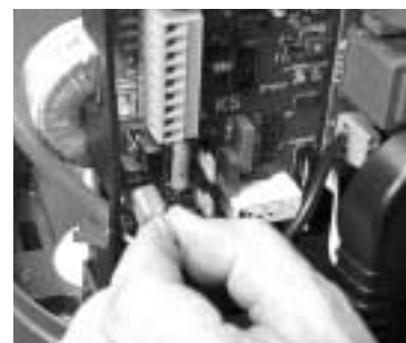
Scollegamento cavi motore da KS
