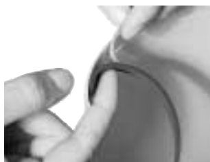
Installation der Dichtung
